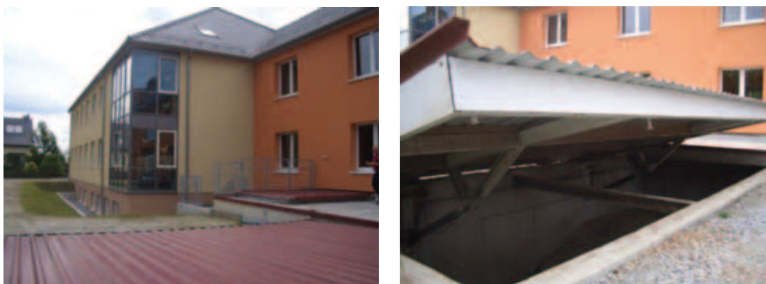
図 7-1 バイオマス熱利用の設置事例（ドイツ：ドレスデン）
