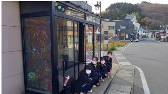
写真4 ステンドグラス設置の様子
