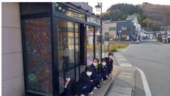
写真4 ステンドグラス設置の様子
